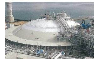
ピットイン式LNG貯槽
