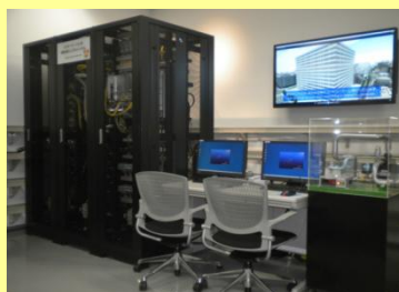
ビル制御システム
